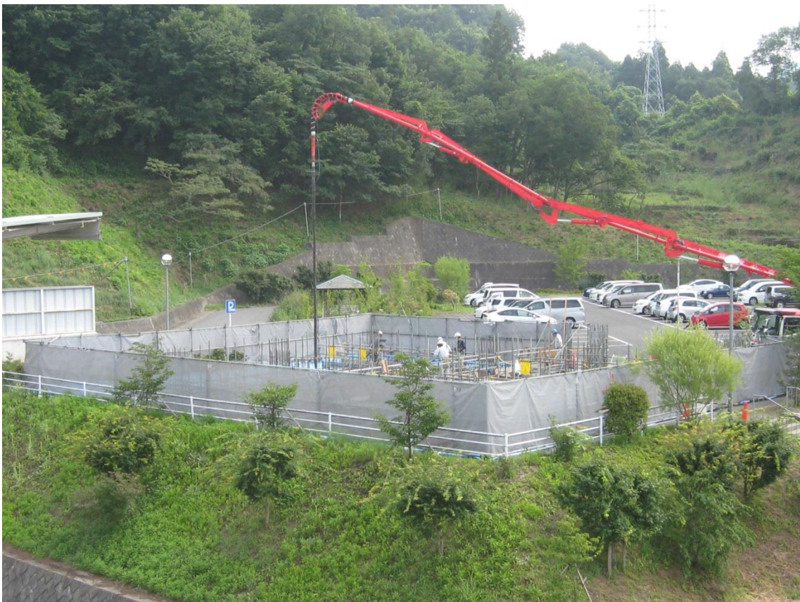
コンクリートの打設状況です。
