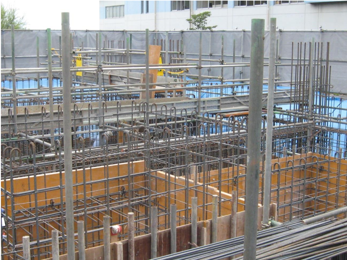
地中梁配筋及びベースコンクリート型枠の状況です。
