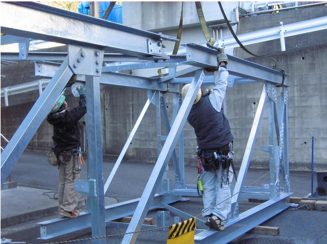
既存棟とタービン棟を繋ぐ配管ブリッジを現場にて組み立てている状況です。
