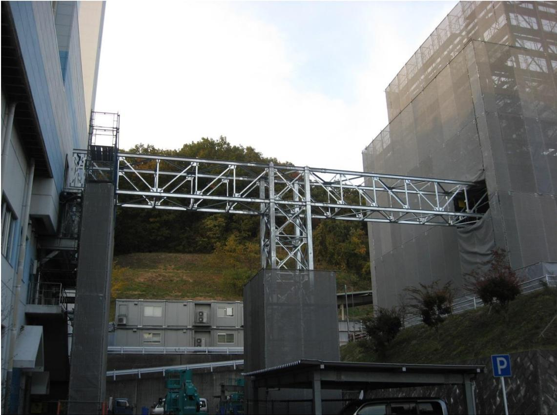
既存棟と蒸気タービン棟が配管ブリッジで接続されました。
