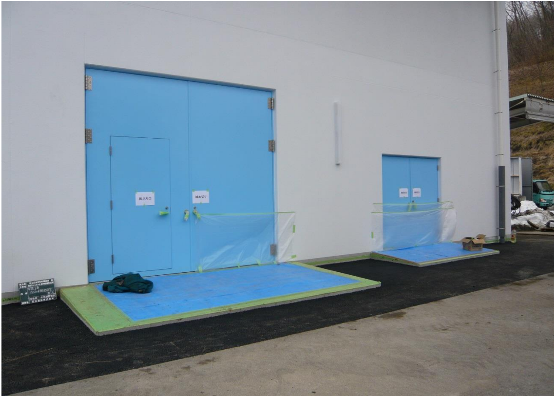
鋼製建具扉の塗装が完了しました。
