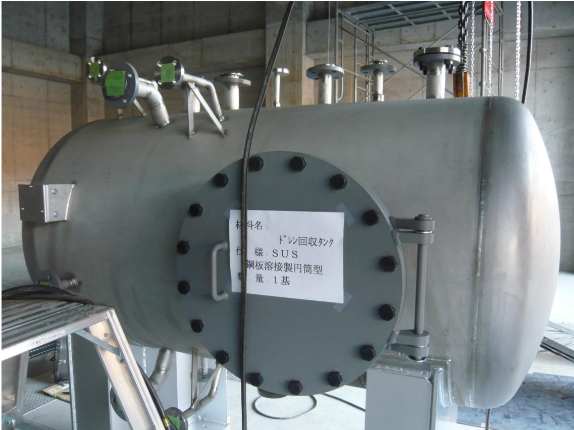
タービン棟に設置する機器（ドレン回収タンク）が搬入されました。
