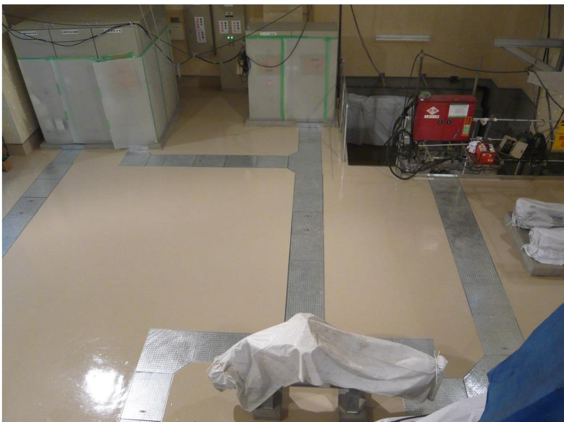
タービン棟 1 階内部の防塵塗装が完了しました。
