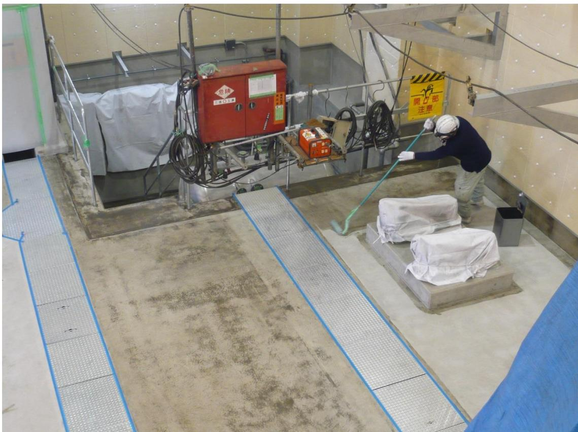
タービン棟 1 階内部の床防塵塗装の下地塗り状況です。
