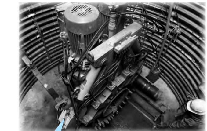
この機械に水道管と掘削用の部品をつけて2か所の立坑(穴)がつながるように掘削する ※写真は地下に約6m掘り下げ作業しています。
