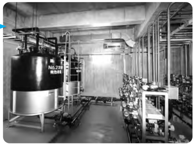
管理棟下の次亜塩素酸ナトリウム注入機室です。3mのタンクが2基あり、前中後次亜を注入しています。地下には、ほかにPAC注入機室があります。
