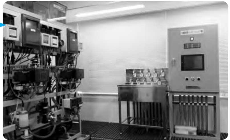
自動水質計器室です。ここでは、沈澱池や配水池などの水の濁りや残留塩素、pHを24時間計測しています。計測したデータは管理室でも確認できます。
