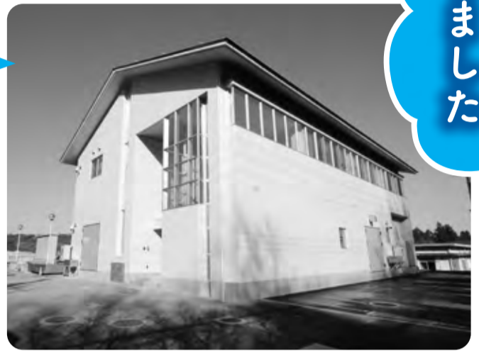
新管理棟です。昭和36年に建設された旧管理棟は老朽化が著しく、早急に更新する必要がありますでしたが平成31年3月20日、無事に竣工式を終えました。
