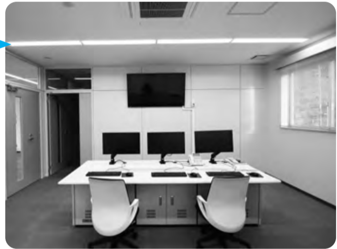
管理室です。ここでは、橋立浄水場や取水ポンプ場の色々な情報が確認でき、機器の操作をすることができます。管理室の奥には制御室があります。
