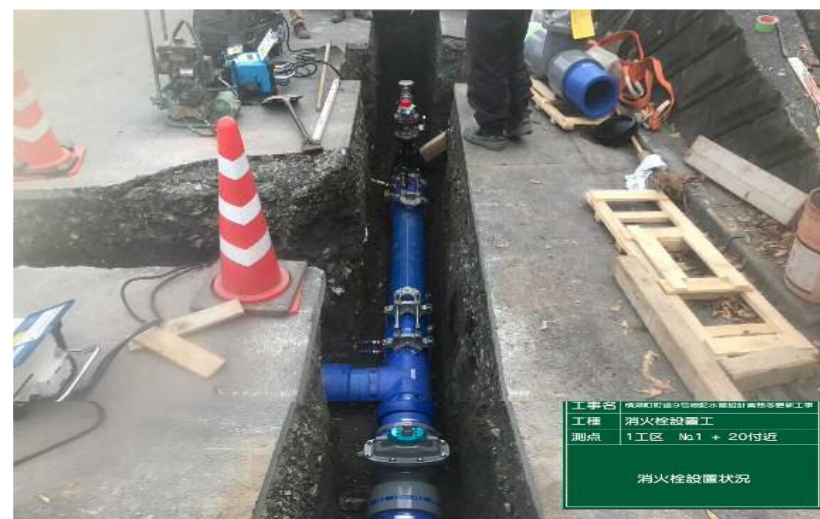
1工区 施工中(中間部)
