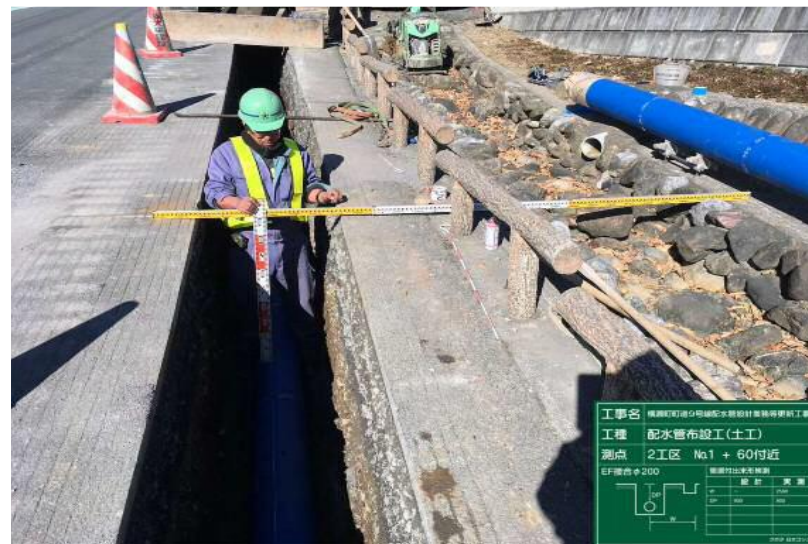
2工区 施工中(中間部)
