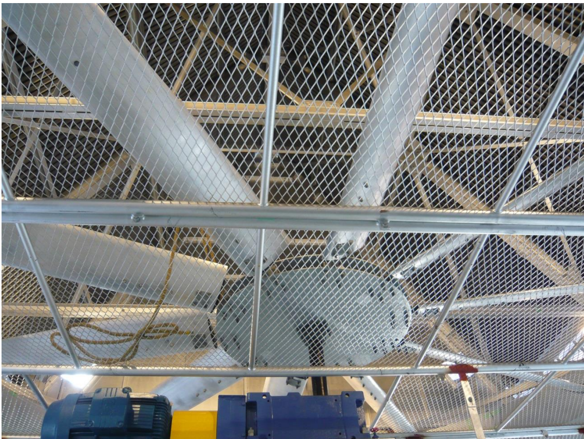
タービン排気復水器の組み立て状況です。
