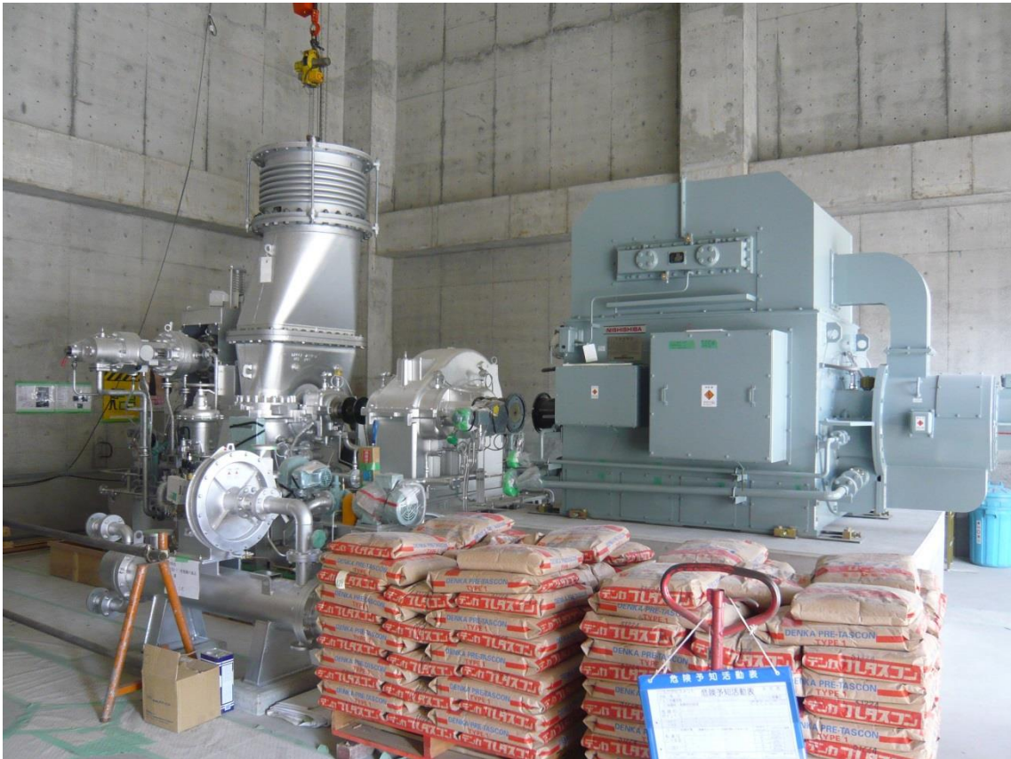
発電機（右側）と蒸気タービン（左側）が据えつけられました。
