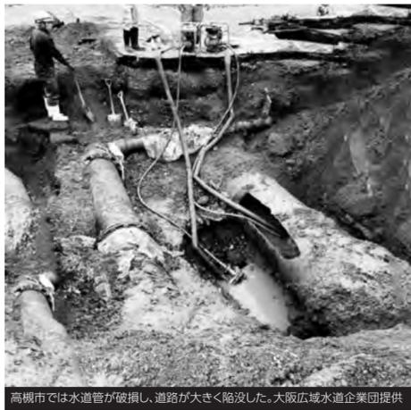
高槻市では水道管が破損し、道路が大きく陥没した。大阪広域水道企業団提供
