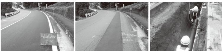
①水道管を交換します ②路面を仮復旧します ③路面を本復旧します
