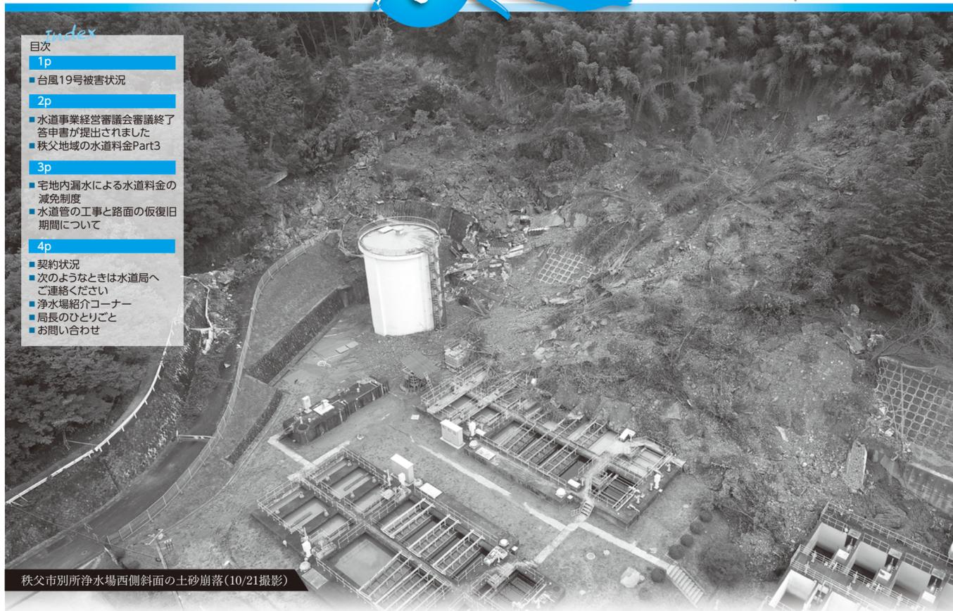
秩父市別所浄水場西側斜面の土砂崩落(10/21撮影)
