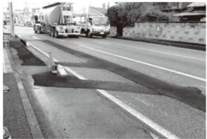
写真のような跡を街中の道路で見かけたことはありませんか?これは道路に埋まっている古い水道管を新しい水道管に交換した跡です。この舗装は仮復旧で、応急処置の状態ですが、後日元通りに本復旧を行います。
