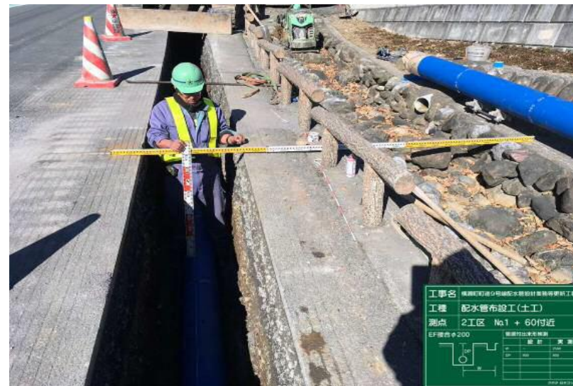
2工区 施工中(中間部)
