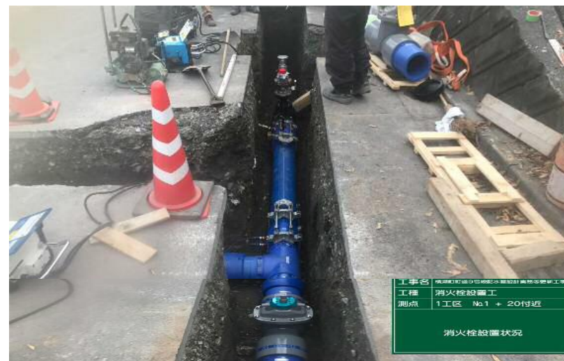
1工区 施工中(中間部)
