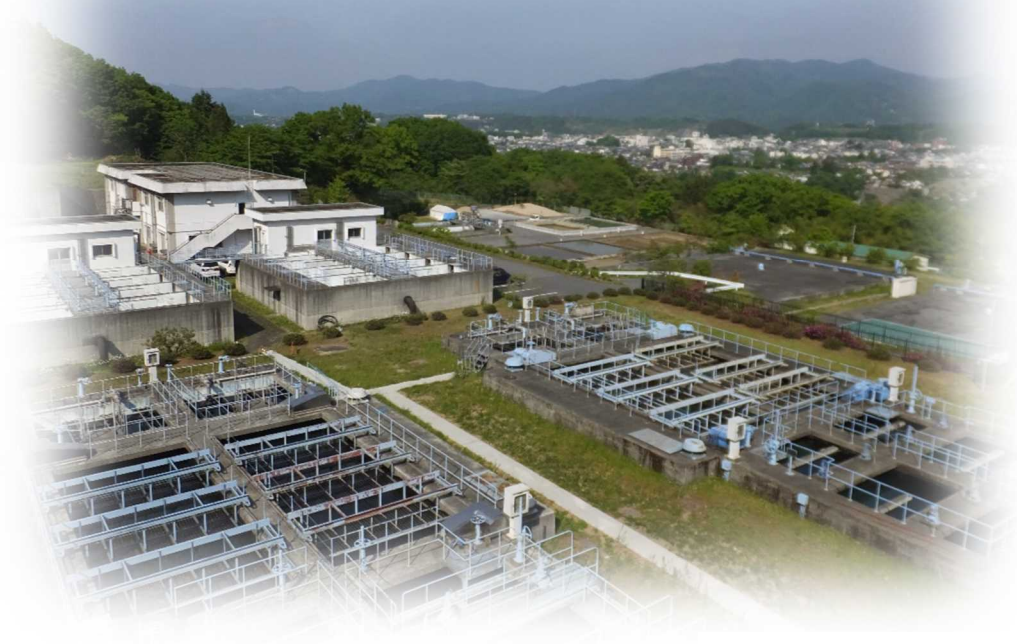
別所浄水場（秩父市）
