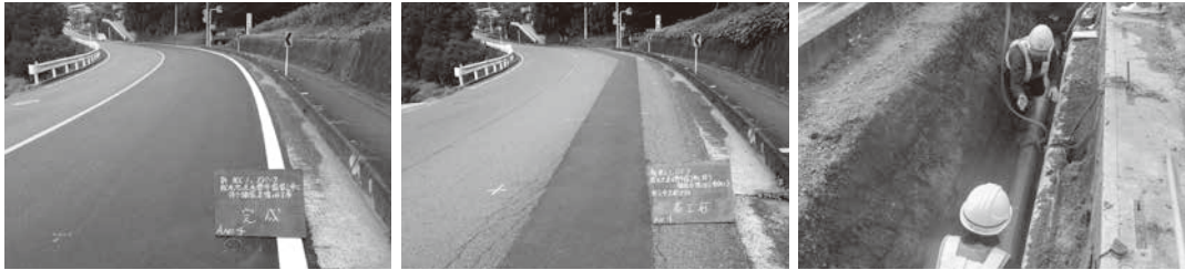
③路面を本復旧します
