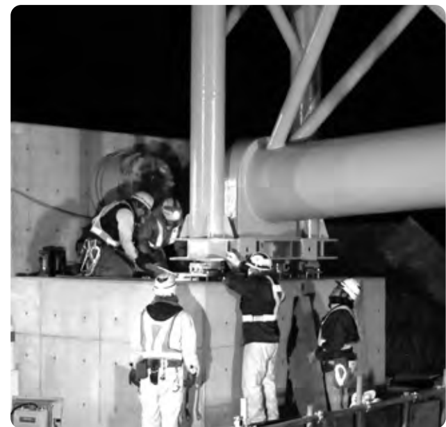
▶クレーンで吊りながら人力で設置か所を調整し据え付け。
