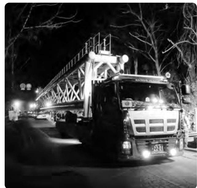
▶水管橋の両端をトレーラに乗せ、橋台付近に移動。22トンありますが車両で運ぶことができます。
