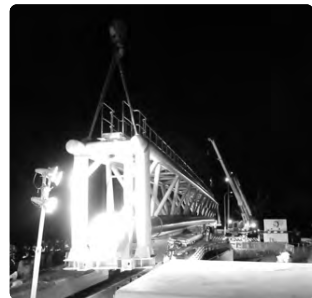
▶水管橋の両端をクレーンで吊り、慎重にクレーンを操作し橋台へ移動。
