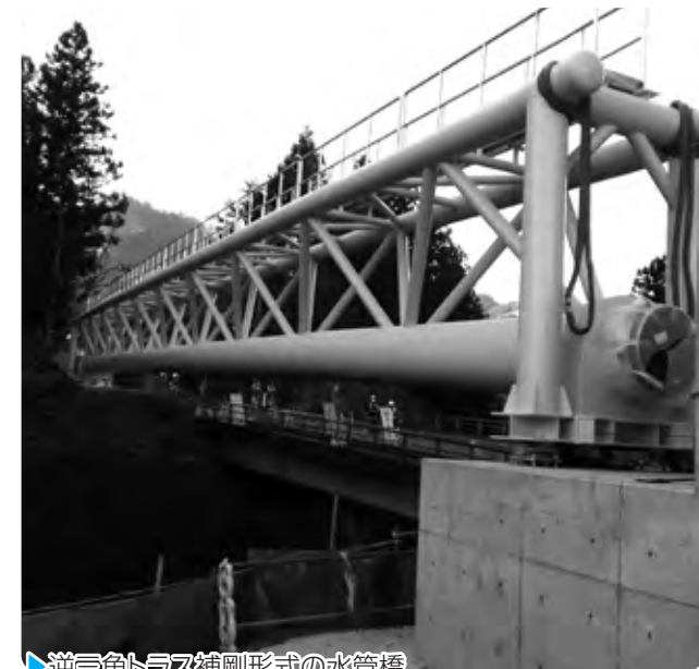
▶逆三角トラス補剛形式の水管橋 三角トラスとは、細長い部材を三角形に繋いだ構造。水道管に補剛部材を増設した水管橋です。
