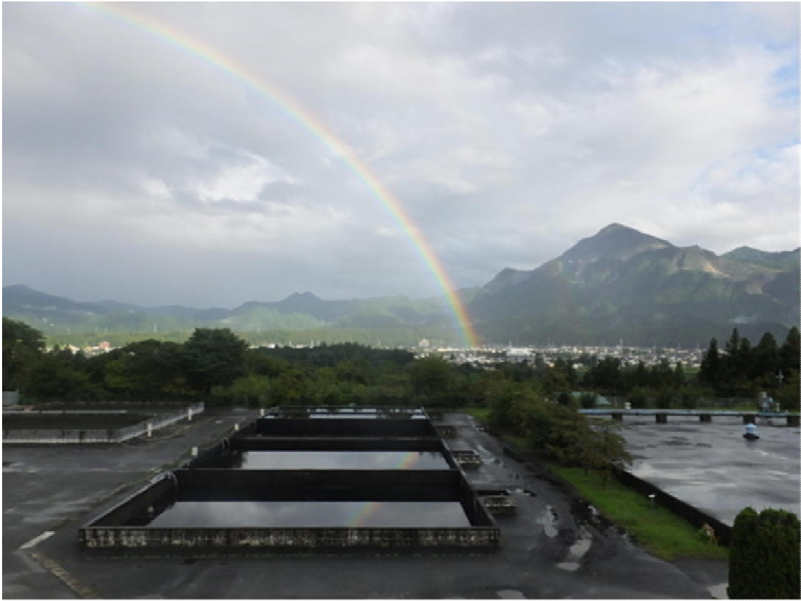
(別所浄水場から秩父市内を望む)
