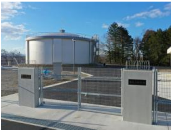
(姿見山配水池 令和7年度竣工)
