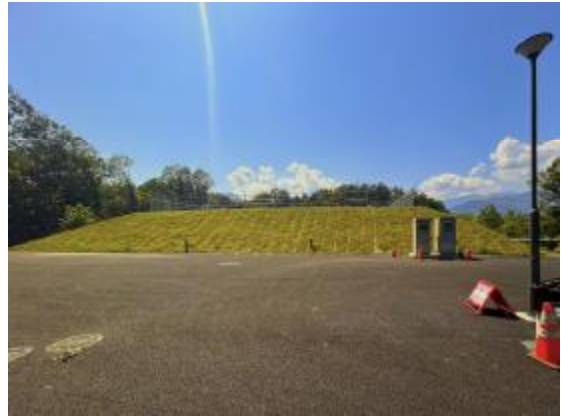
(新秩父ミュージックパーク配水池 令和7年10月竣工)
