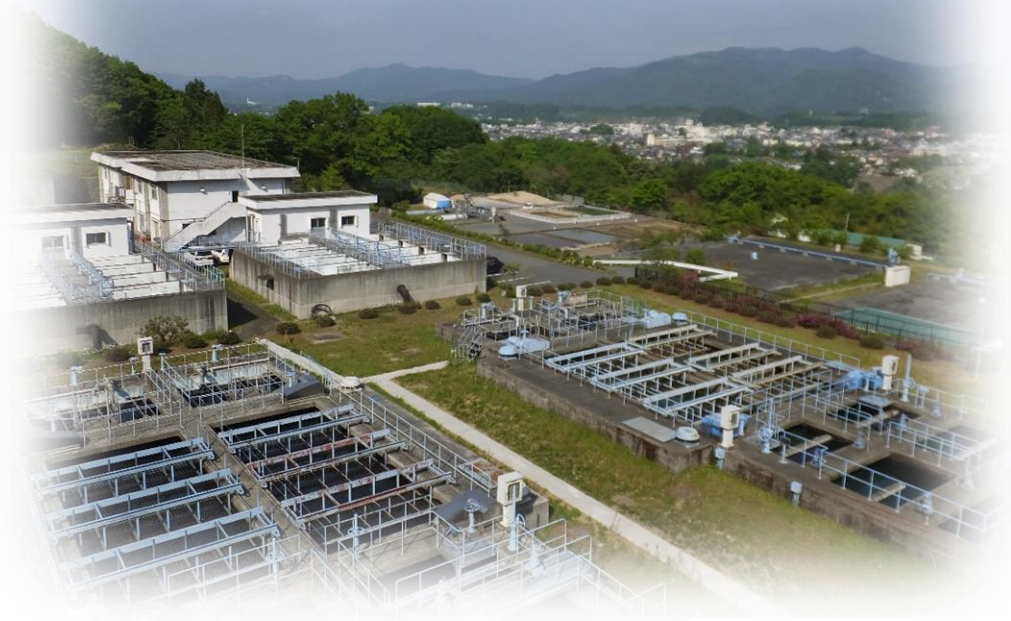
別所浄水場（秩父市）
