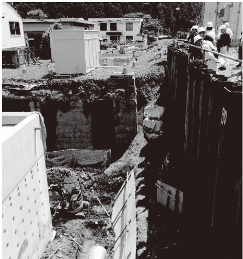
橋立浄水場 建設中の配水池
