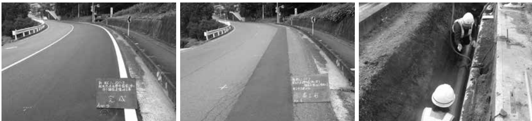
③路面を本復旧します
