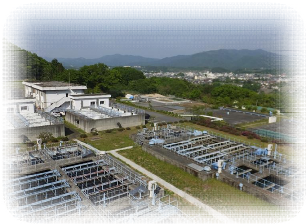
別所浄水場（秩父市）
